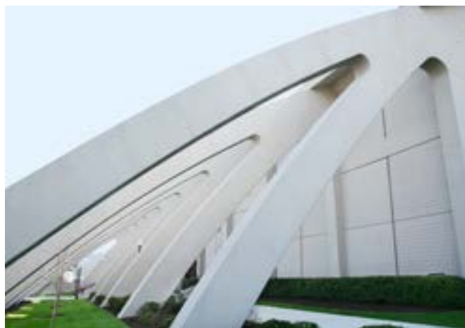
Renovação Cassell Coliseum, Virgínia, EUA - Depois
