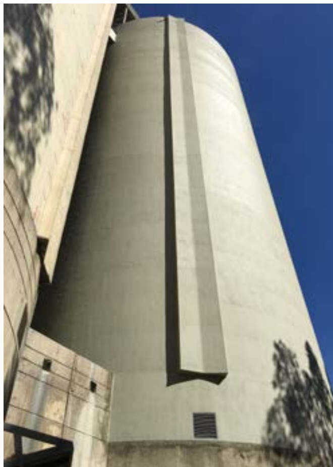
Reparação de Silos no Líbano - Depois
