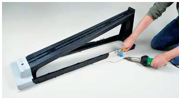
Soldar Sika® SolarClick na membrana de impermeabilização
