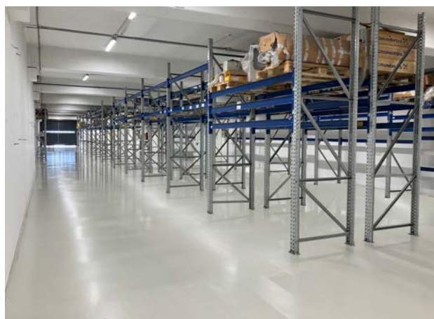
Armazéns de médio tráfego e oficinas
