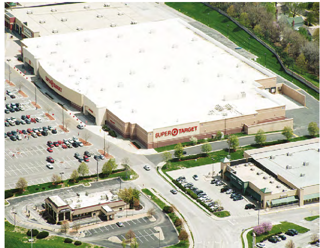
Exemplo de uma cobertura fria nos EUA
