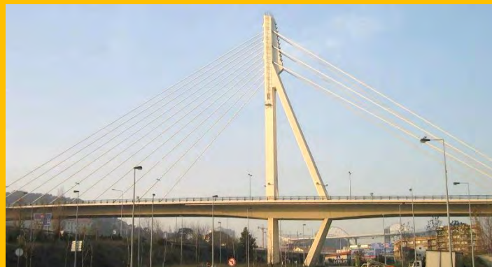
Viaduto Avenida 25 de Abril - Porto
