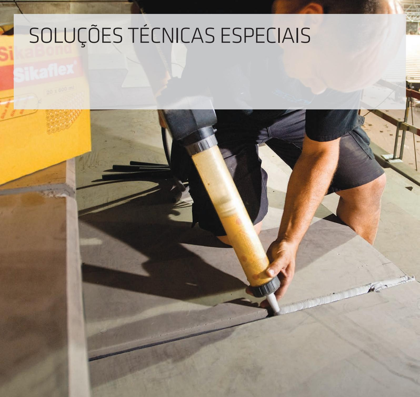
Os selantes de juntas adequados ajudam a proteger o meio ambiente contra a contaminação, especialmente os lençóis freáticos, em áreas destinadas ao armazenamento e manuseamento de produtos quimicamente agressivos e líquidos poluentes, tais como postos de abastecimento, baciais de retenção e tanques de armazenagem.
