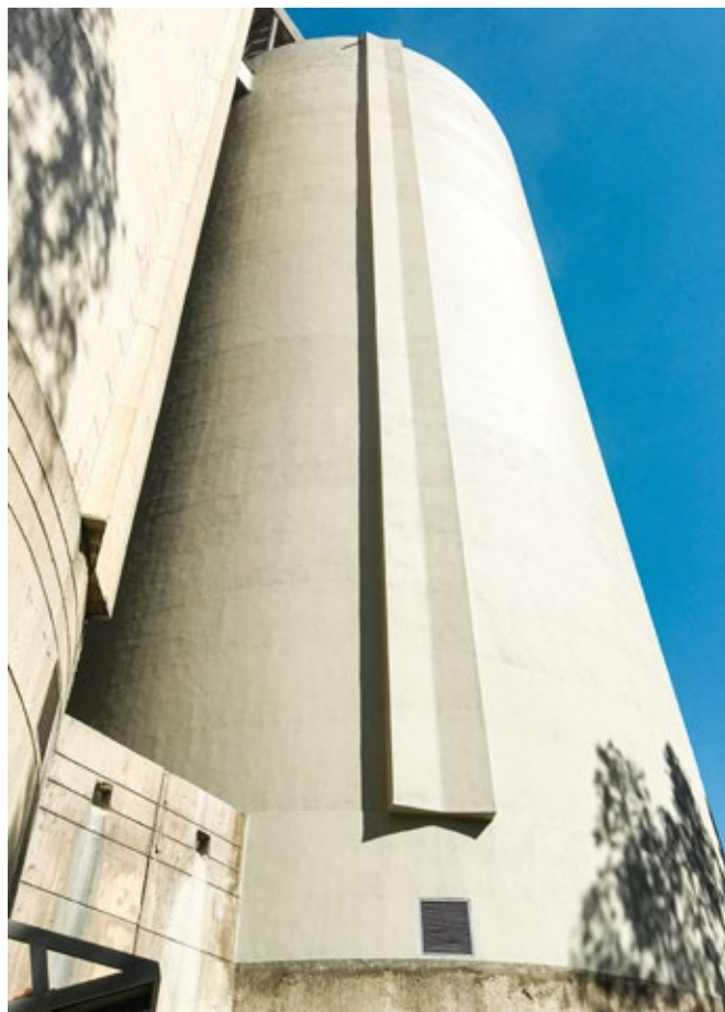
Reparação de Silos no Líbano - Depois
