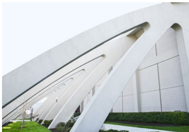
Renovação Cassell Coliseum, Virgínia, EUA - Depois
