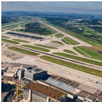
REPARAÇÃO E PROTEÇÃO DE BETÃO
