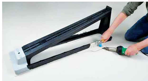
Soldar Sika® SolarClick na membrana de impermeabilização
