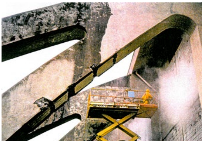
Renovação Cassell Coliseum, Virgínia, EUA - Antes
