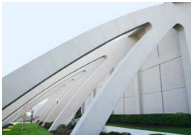
Renovação Cassell Coliseum, Virgínia, EUA - Depois
