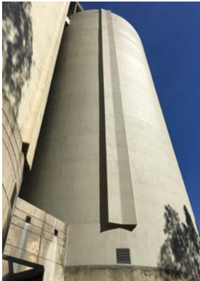
Reparação de Silos no Líbano - Depois
