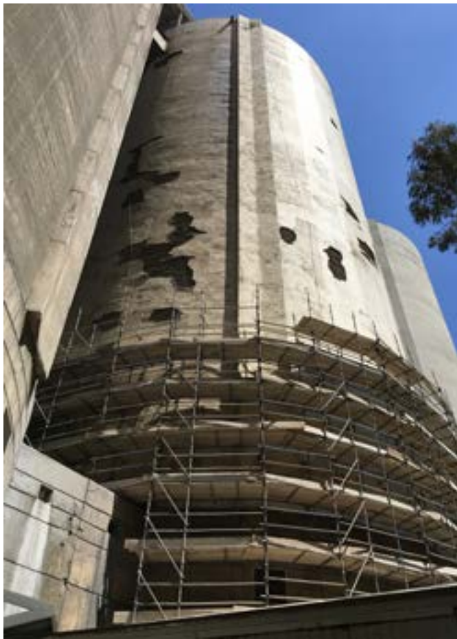
Reparação de Silos no Líbano - Antes
