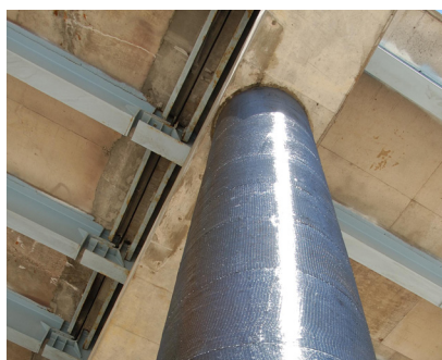
REFORÇO DE PILARES
