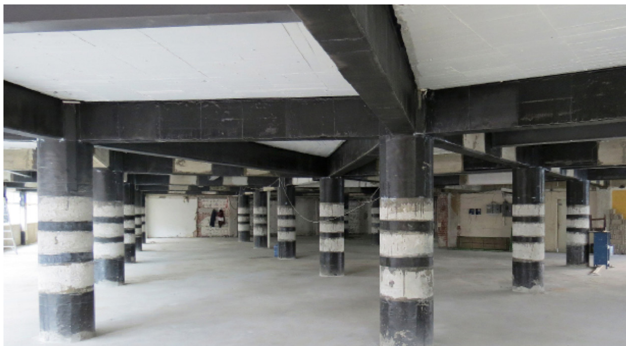
Vigas e colunas reforçadas com SikaWrap®
