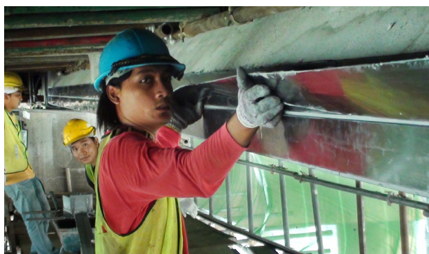
Instalação de CarboDur®
