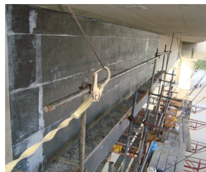
Reforço com SikaWrap®
