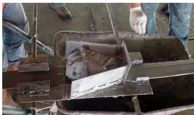
Revestimento das placas CarboDur® com Sikadur®
