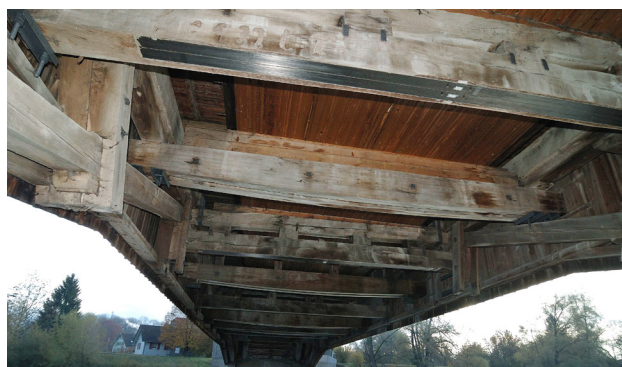
Viga transversal reforçada com CarboDur®
