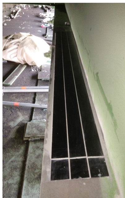
Duas camadas de Sika CarboDur®
