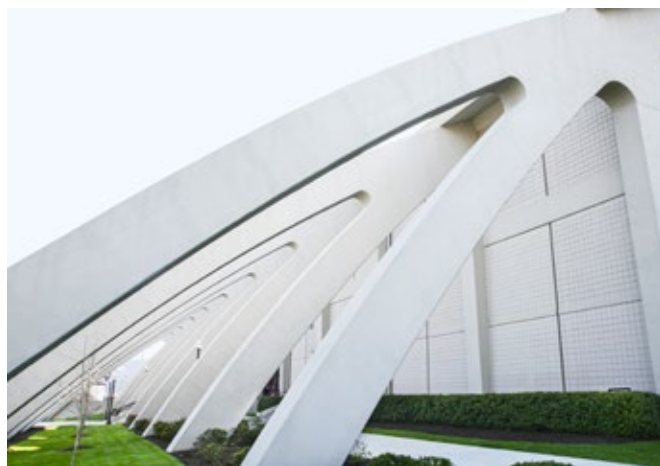
Renovação Cassell Coliseum, Virgínia, EUA - Depois
