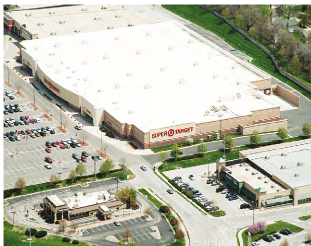
Exemplo de uma cobertura fria nos EUA
