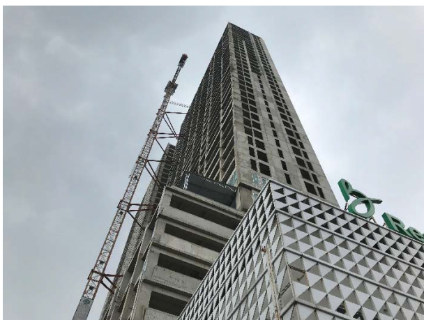
Edifício típico pré-fabricado de grande altura
