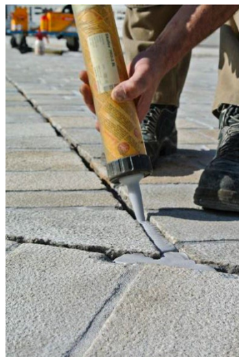
Aplicação de selante de pavimentos
