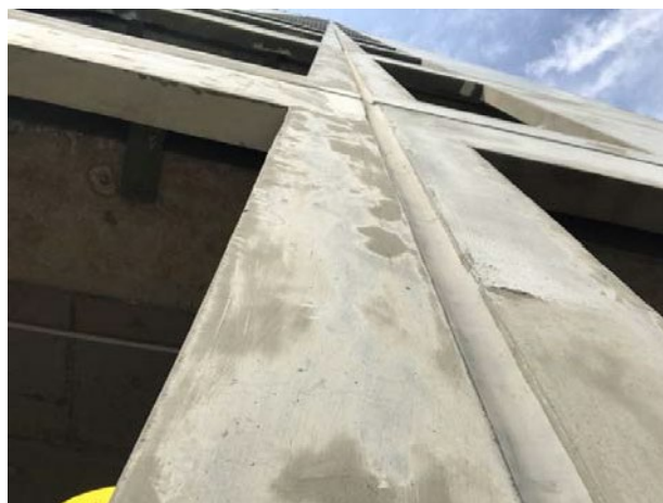
Junta de dilatação em betão pré-fabricado
