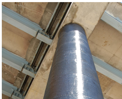
REFORÇO DE PILARES
