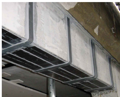
REFORÇO DE VIGAS
