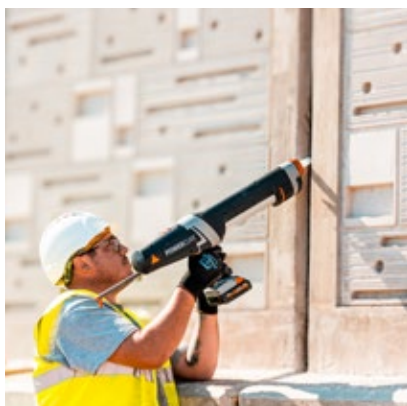
SELAGEM DE JUNTAS
