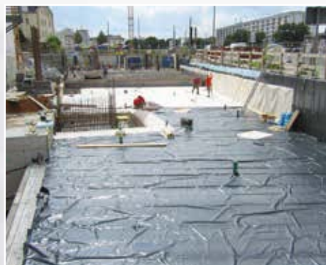
Laje de fundação
