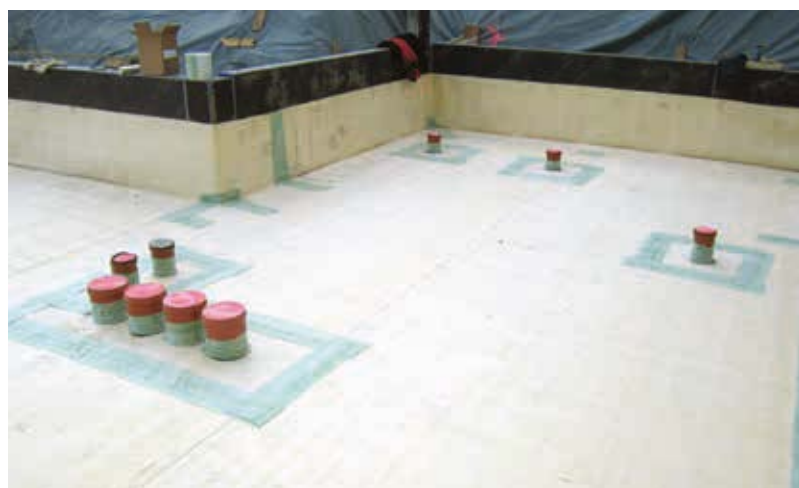
Pormenores de juntas internas finalizado
