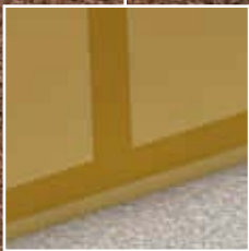
Juntas de construção
