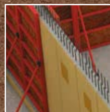
Paredes – cofragem dupla Juntas de dilatação
