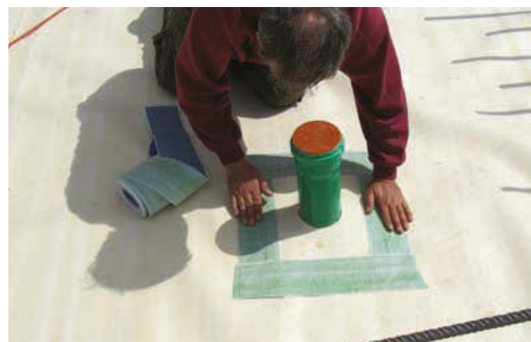
Pormenores de juntas internas com SikaProof® Tape-150
