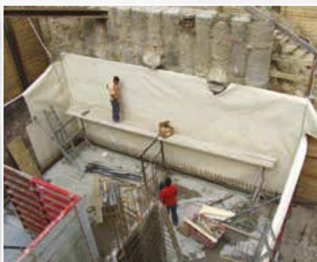
Paredes, cofragens de uma ou dupla face
