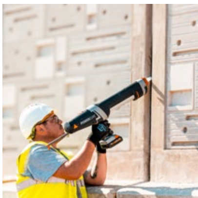
SELAGEM DE JUNTAS
