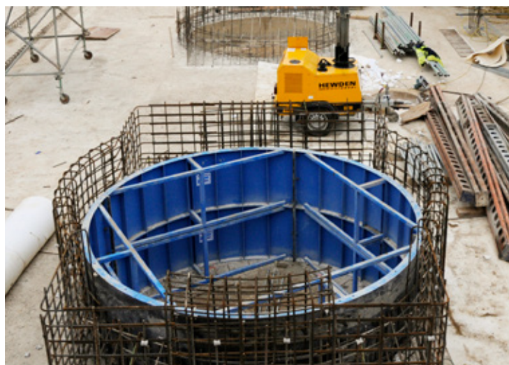
Estação de abastecimento de combustível – Revestimentos protetores Sikagard®.
