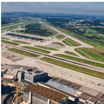
REPARAÇÃO E PROTEÇÃO DE BETÃO
