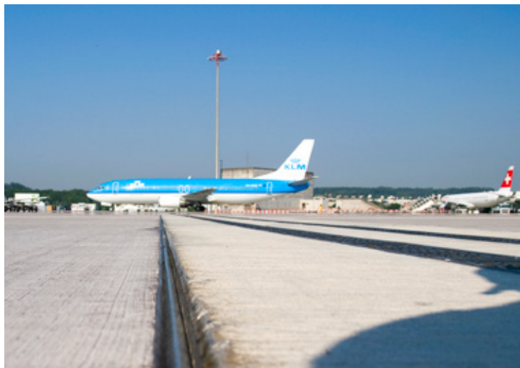
Selantes de alta performance e materiais para reparação de betão da Sika no Aeroporto de Zurique.
