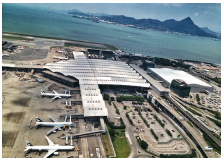
Membrana de cobertura de camada única Sika Sarnafil® no edifício principal do terminal do Aeroporto Internacional de Hong Kong.
