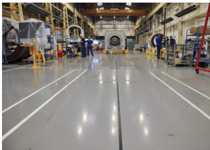
Durabilidade, facilidade de limpeza e sinalização proporcionadas pelo Sikafloor® numa instalação de manuseamento de carga.
