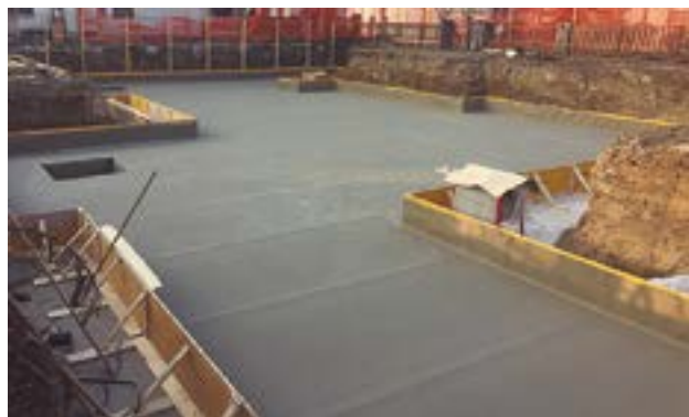
Aplicação comum de SikaProof® A+ em laje de fundação.
