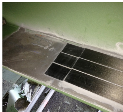
Duas camadas de Sika CarboDur®
