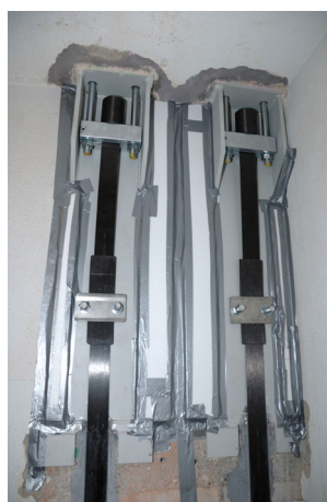
Ancoragem do Sistema Sika CarboStress
