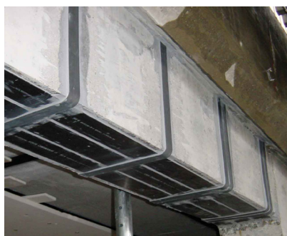
REFORÇO DE VIGAS
