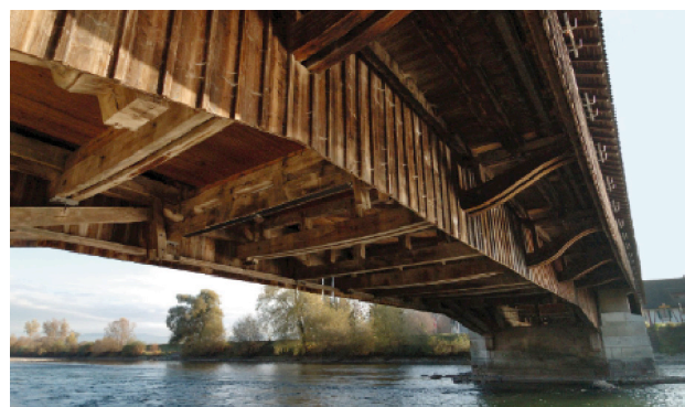
Vista inferior do sistema de reforço
