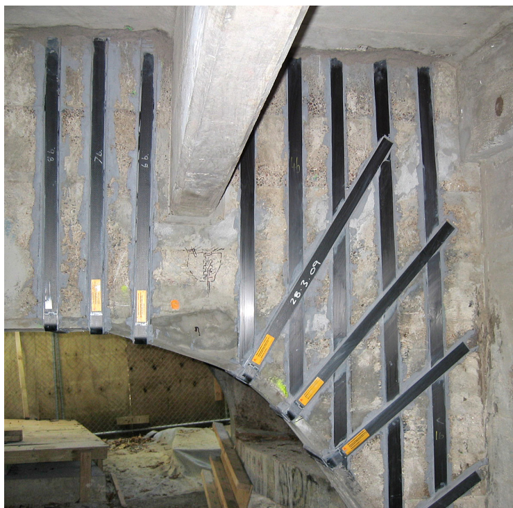
Faixas Sika CarboDur® e placas CarboShear L coladas à estrutura de betão.
