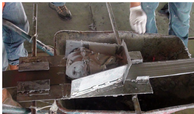
Revestimento das placas CarboDur® com Sikadur®
