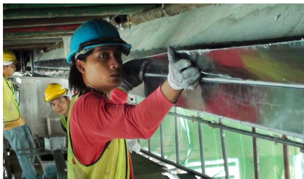
Instalação de CarboDur®
