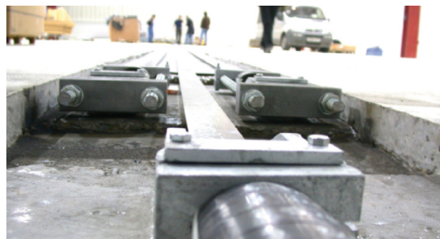
Canal base com placas CFRP tensionadas postas.
