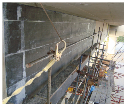
Reforço com SikaWrap®
