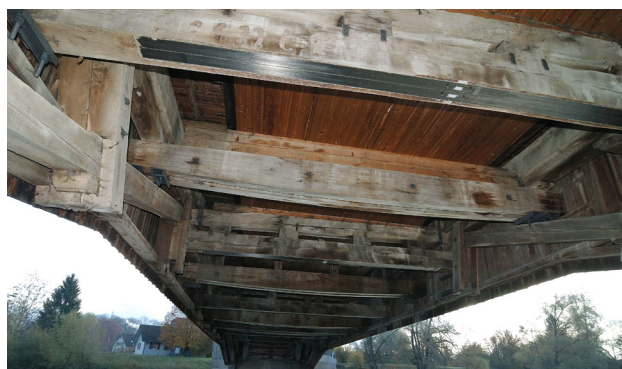
Viga transversal reforçada com CarboDur®
