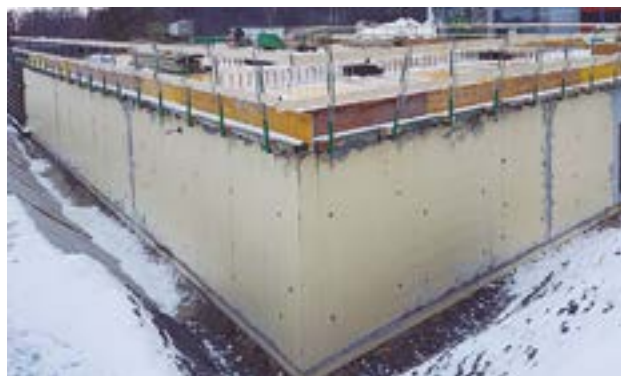
Escavação aberta com SikaProof® A+: Após a remoção da cofragem, as tiges têm de ser seladas.
