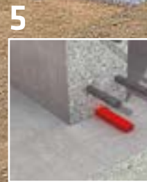
5 Sika®Swell - perfis hidroexpansivos de impermeabilização de juntas
