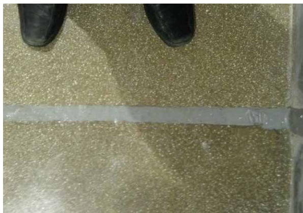
Detalhes da junta de movimentação
