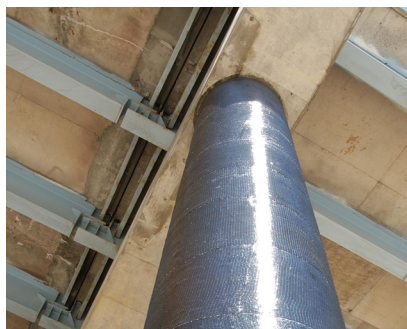
REFORÇO DE PILARES
