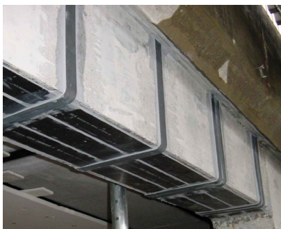
REFORÇO DE VIGAS
