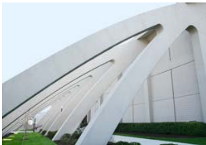
Renovação Cassell Coliseum, Virgínia, EUA - Depois
