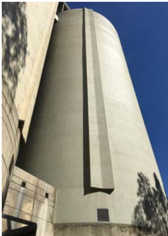
Reparação de Silos no Líbano - Depois
