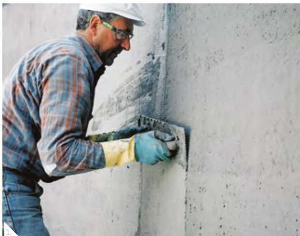
Argamassas de impermeabilização
