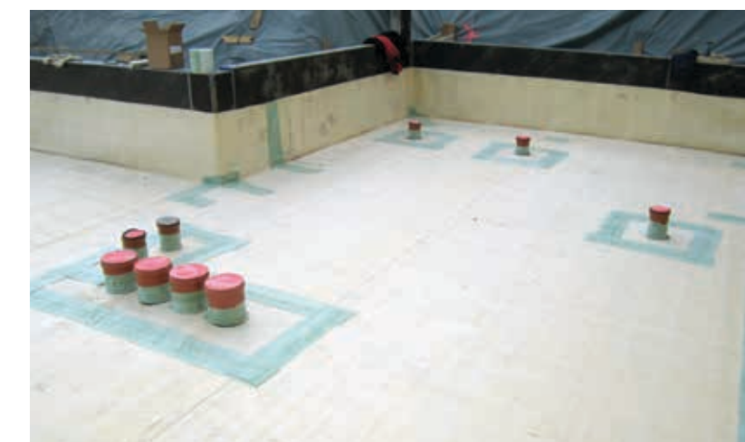
Pormenores de juntas internas finalizado
