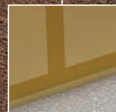
Juntas de construção
