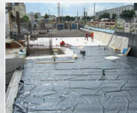
Laje de fundação
