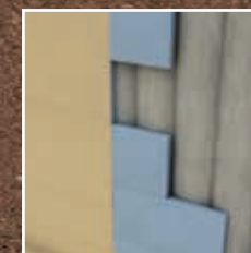
Paredes - cofragem simples
