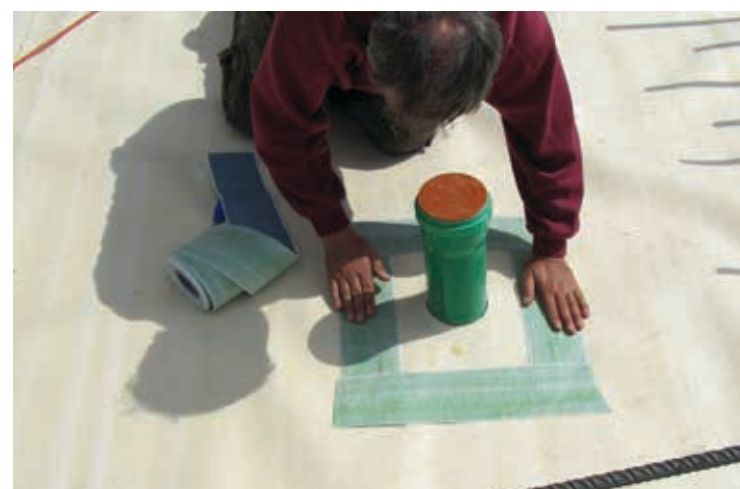
Pormenores de juntas internas com SikaProof® Tape-150
